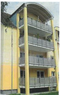
Umbau ehemalige Kaserne
