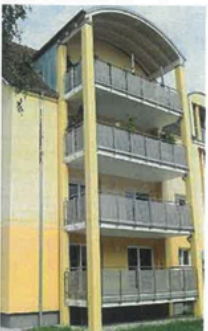
Umbau ehemalige Kaserne
