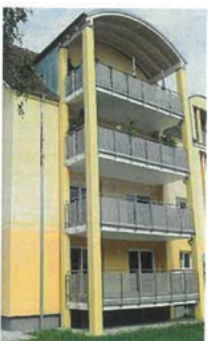
Umbau ehemalige Kaserne
